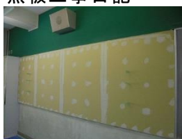
①黒板の基礎工事
